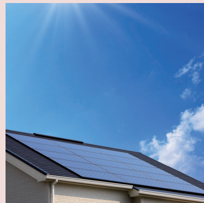
太陽光発電システム & 蓄電池搭載
