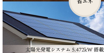
太陽光発電システム 5.472kW 搭載
