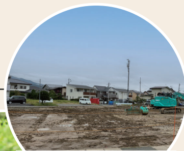
▲ 造成工事の様子
